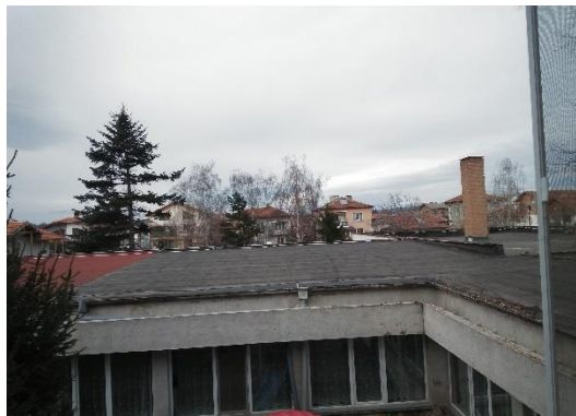
Фиг.1.9. Изглед на покрив Тип 1
