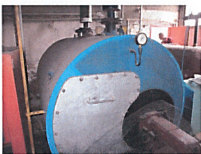
Фиг11. Водогрейни котли-не работещи
