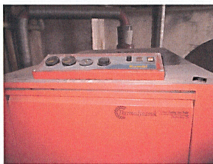
Фиг11. Водогрейни котли-не работещи
