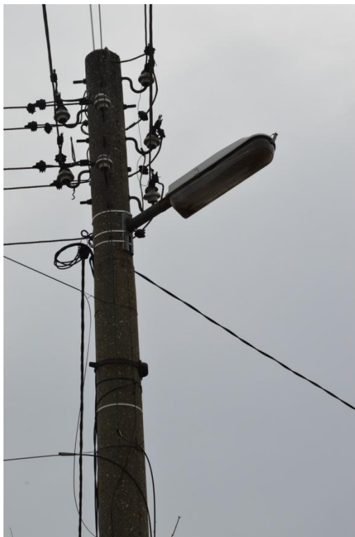
Осветител с 55 W КЛЛ монтиран на стоманобетонен стълб
